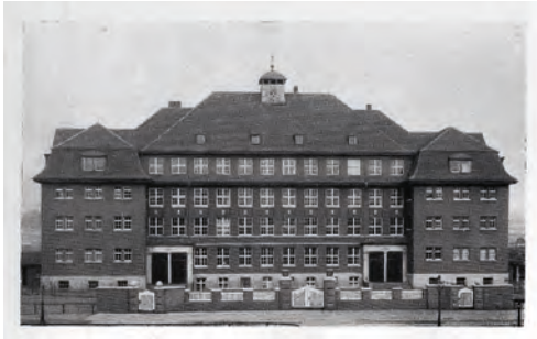
Abb. 6: Das Gebäude der ehemaligen Cecilienschule, ca. 1912.
